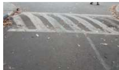
Fig. 1. Calle con reductor de velocidad señalizado [1].
